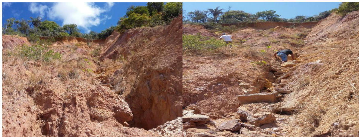
Figura 3. Processos erosivos instalados em parte de vertente na APA do Morro do Urubu. Fonte: Trabalho de Campo, 2016.
