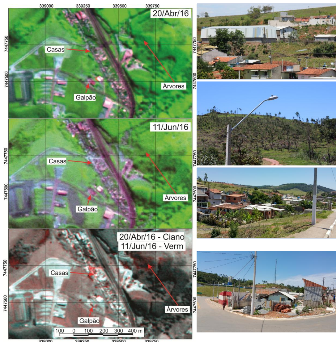
Figura 7. Imagens e as fotografias correspondentes na área do Bairro 3 Pistas. Nas fotografias, pode-se observar a perda da cobertura de um galpão, a quebra de árvores, casas com novos telhados e casas destelhadas.
