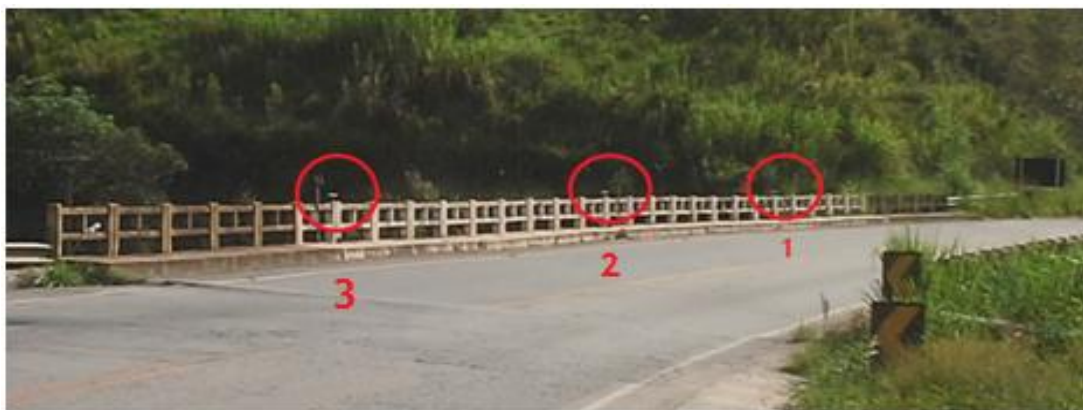
Figura 1 - Distribuição dos pontos fixos sobre a ponte.
