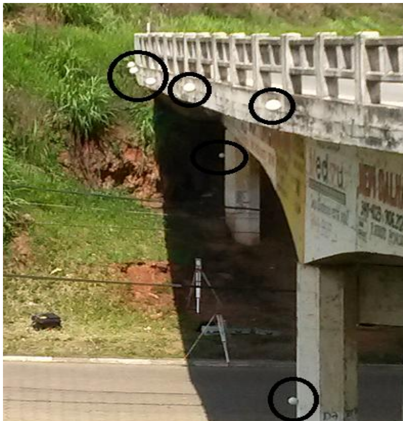
Figura 2 - Alvos esféricos distribuídos pela estrutura, para junção das cenas.
