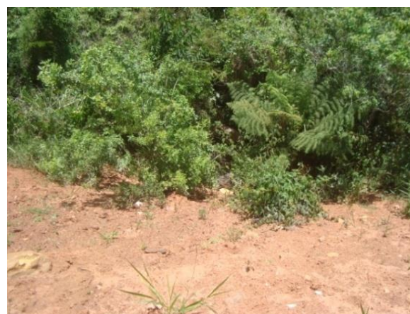
FIGURA 5- Terraplanagem na rua Capitão Lúcio, próximo ao curso d'água.
