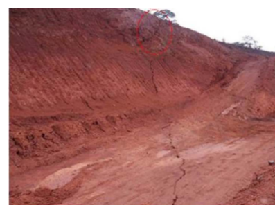
Figure 2: N5W meu com evidência de banco rachado. Fonte: [1].
