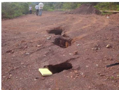
Figure 3: NSW meu com evidência de buracos na estrada de acesso. Fonte: [1].
