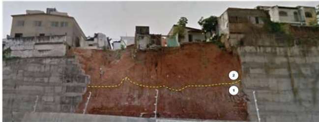
Figura 4. Fotografia expondo os materiais inconsolidados residuais das formações Barreiras em (1) e Potengi em (2), justamente no setor da comunidade em que houve um corte de talude realizado de maneira errônea que favoreceu o tombamento de um muro de arrimo.
