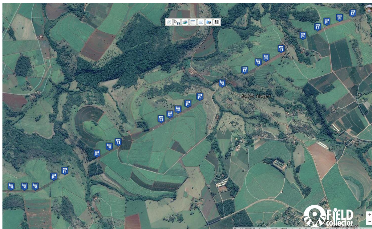
Figura 5. Apresentação da espacialização das torres inspecionadas no Módulo Web.
