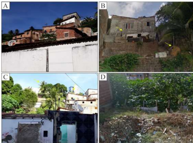
Figura 5. Fatores antrópicos que facilitam a desestabilização dos taludes. Em (A) concentração habitacional ao longo da encosta, (B) encanamentos e fossa séptica indevidamente instalados, indicados pelas setas amarelas, (C) árvores de grande porte cultivadas no substrato inclinado, com destaque a coqueiro e bananeira, evidenciados por setas amarelas e em (D) encosta com descarte de resíduos sólidos. Todas essas situações comprometem a coesão do solo e assim favorecem a deflagração de movimentos de massa.
